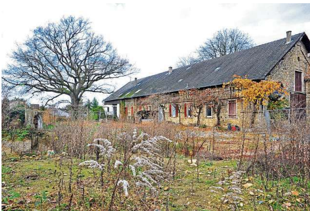
Was mit dem Gebäude der ehemaligen Kelterhalle des früheren Weingutes Niedecken hinter der Präsident-Mohr-Schule geschieht, darüber muss der Stadtrat Ingelheim entscheiden. Foto: Thomas Schmidt
